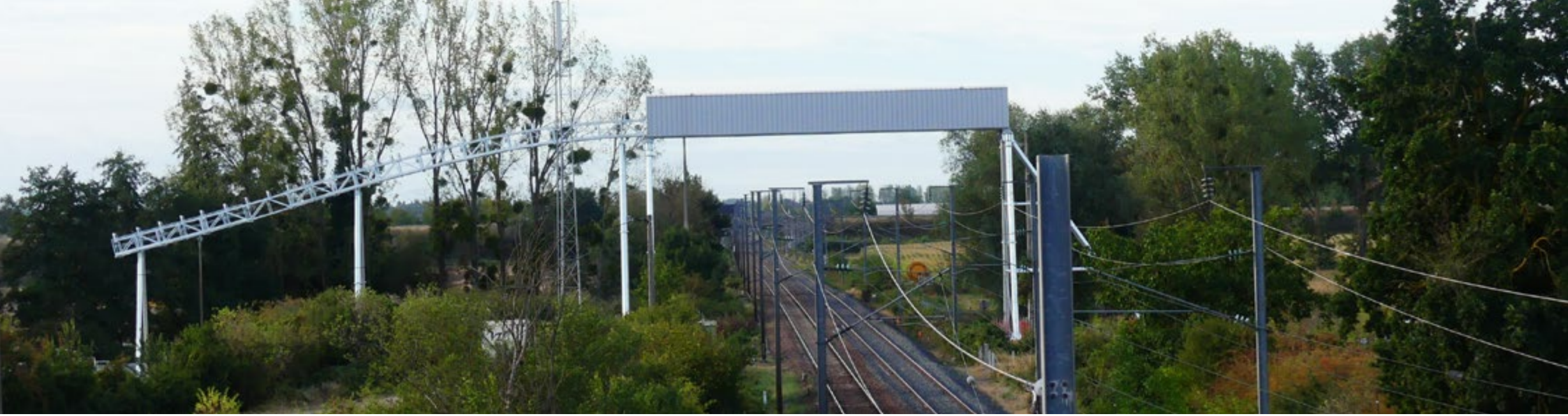
Bande transporteuse de matériaux
